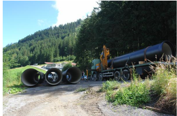
Les canalisations DN 1 400
