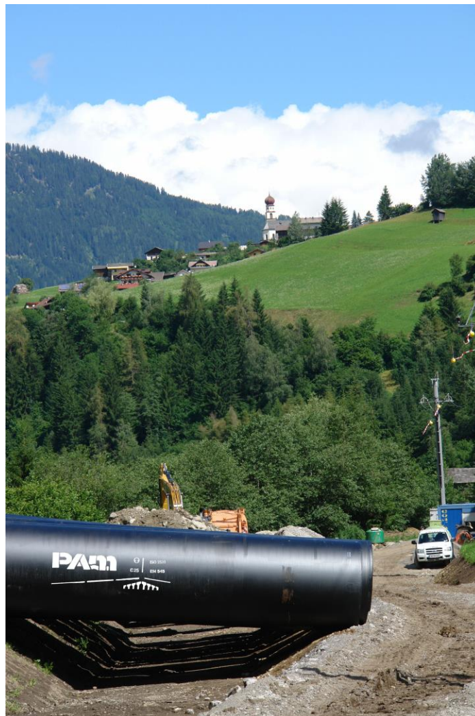
Vue générale du site avec les canalisations
